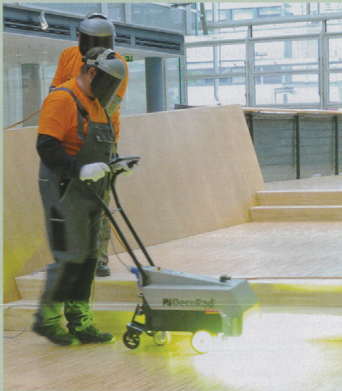
Das Versiegelungsgerät im Einsatz: Schnell ist der Raum zum Einrichten bereit.
