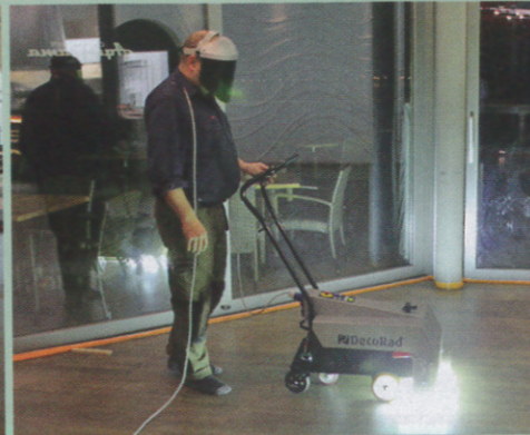
5. Der Handwerker härtet die Lackschicht mit UV-Licht aus.
