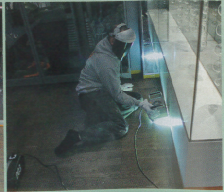
6. Die Randbereiche werden mit einer kleinen UV-Maschine ausgehärtet. Der Boden ist sofort nutzbar.
