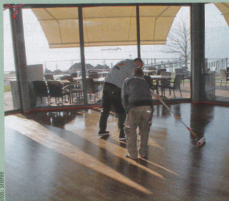
4. Eine zweite Lackschicht wird auf dem Parkettboden aufgetragen.
