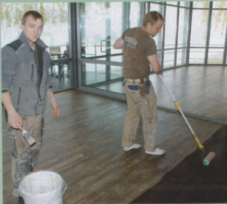
1. Nach dem Schleifen, Spachteln und Grundieren wird die erste Lackschicht aufgetragen.
