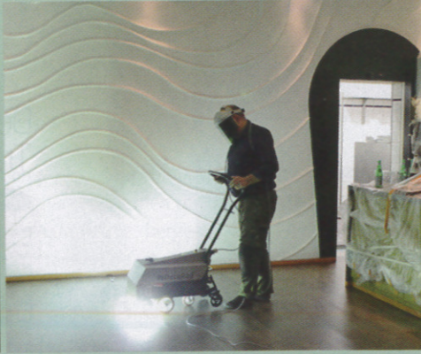
2. Mit der UV-Maschine wird die Lackschicht ausgehärtet.
