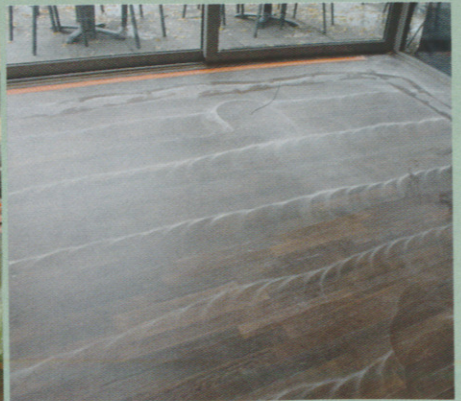
3. Daraufhin führt der Handwerker einen Zwischenschliff durch.
