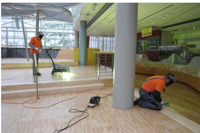
Die neue Technologie kombiniert die Vorteile der wasserbasierten Lacktechnologie mit den positiven Trocknungseigenschaften von ultraviolettem Licht. Das innovative Versiegelungsprodukt LOBACURE WS Rush A.T. wird dabei durch ein mobiles Gerät mit UV-Lampe vor Ort getrocknet und gehärtet. Der umweltfreundliche Lack ist für alle
