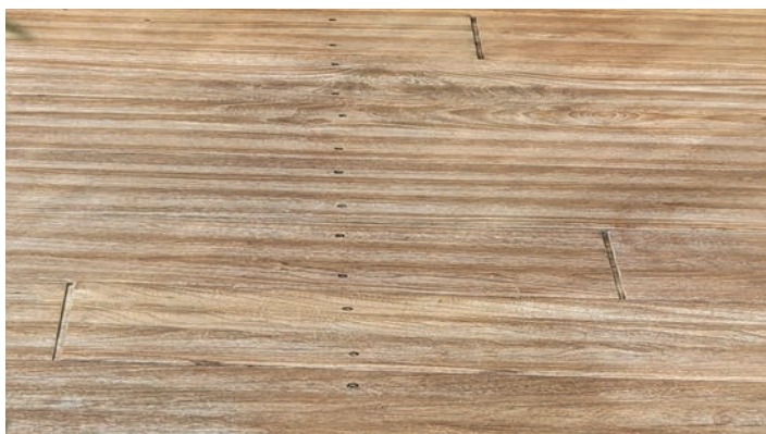
Preperela terasa s termično obdelanim lesom po odstranjevanju sive barve z DeckDegrayerjem.
