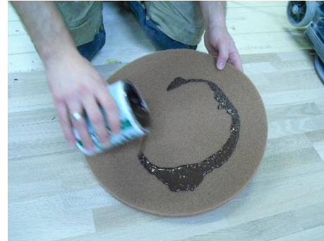
Auftragen von LOBASOL® HS 2K ImpactOil Color auf das Pad
