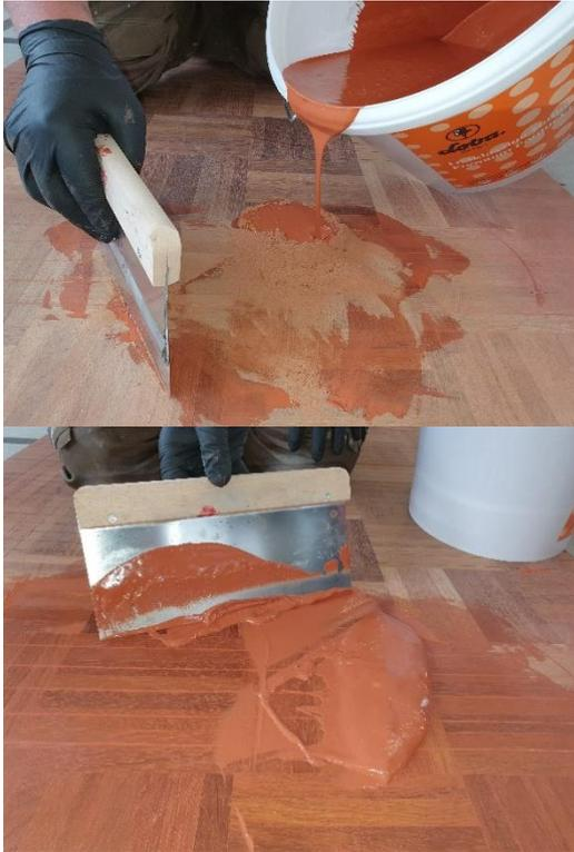
Die eingefärbte Kittmasse kann nun wie gewohnt verarbeitet werden. Anmischen mit passendem, möglichst feinem Holzstaub, Mischungsverhältnis 1:10.
