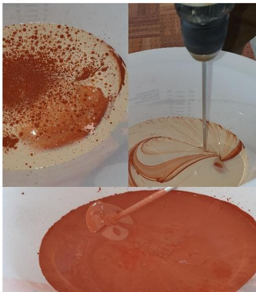
Mithilfe des Farbmischers und Akkuschaubers werden die beiden Komponenten sorgfältig gemischt, bis eine homogene Masse entstanden ist (ca. 2 Minuten rühren). Der Farbmischer sollte dabei auch durch den Versiegelungseimer bewegt werden, um eine gleichmäßige Durchmischung zu erreichen. Es ist darauf zu achten, dass keine Farbnester im Eimer verbleiben.
